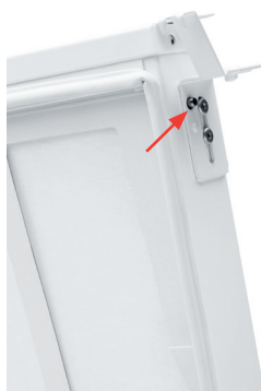
Lägg märke till att låssprinten blir synlig då haken är låst
